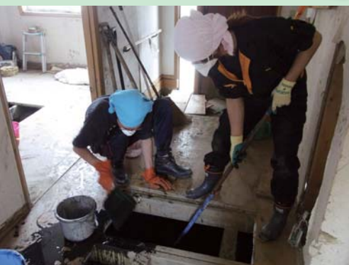
床下に堆積した泥のかき出し作業
