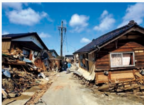
石川県珠洲市宝立地区の木造住宅被害（2024年2月4日）
